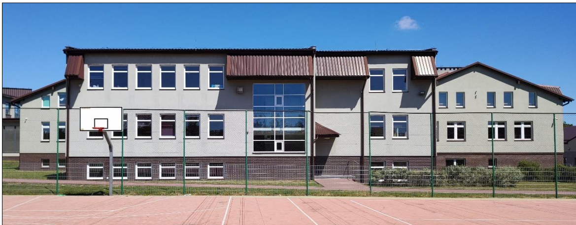
Rys. 6 Widok obiektu Zespołu Szkolno-Przedszkolnego w Borkowie zarejestrowany z kierunku południowego.
