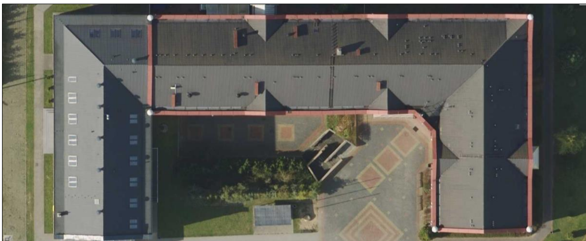
Rys. 23 Widok satelitalny połaci dachowych SP w Rotmance predestynowanych do zabudowy modułami fotowoltaicznymi.
