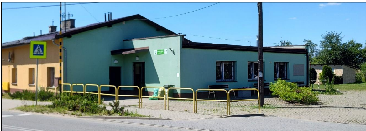
Rys. 58 Widok główny obiektu Świetlicy Wiejskiej w Goszynie zarejestrowany z kierunku południowo-wschodniego.
