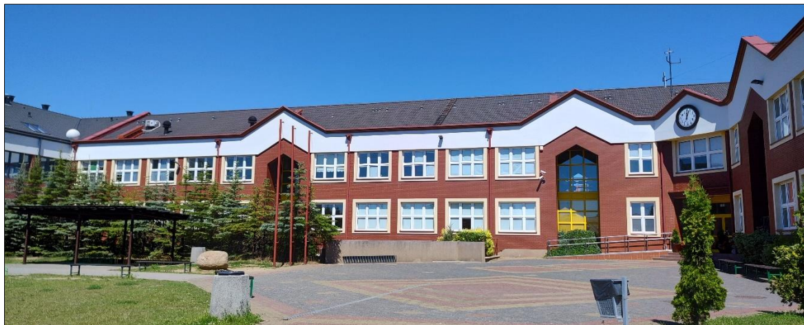
Rys. 22 Widok główny obiektu Szkoły Podstawowej im. Karola Wojtyły w Rotmance zarejestrowany z kierunku południowego.
