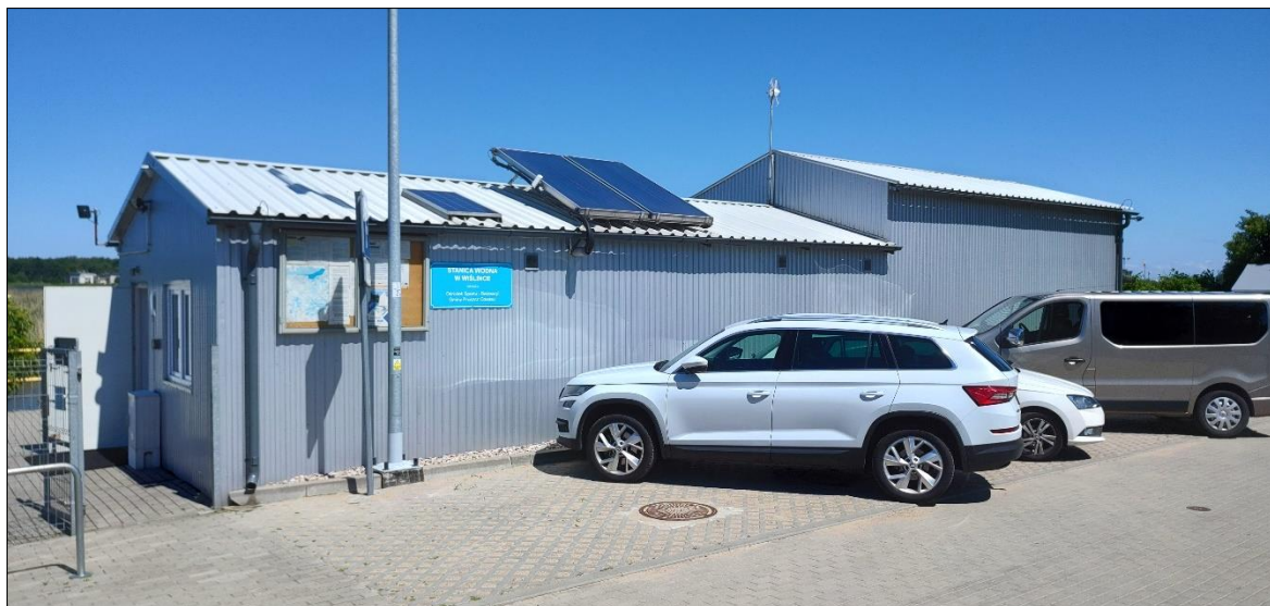
Rys. 50 Widok główny nieruchomości Stanicy Wodnej w Wisłince zarejestrowany z kierunku południowo-zachodniego.
