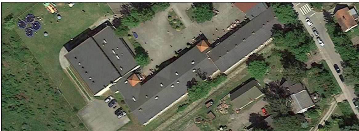
Rys. 35 Widok satelitarny połaci dachowych SP w Wiśliniec predestynowanych do zabudowy modułami fotowoltaicznymi.
