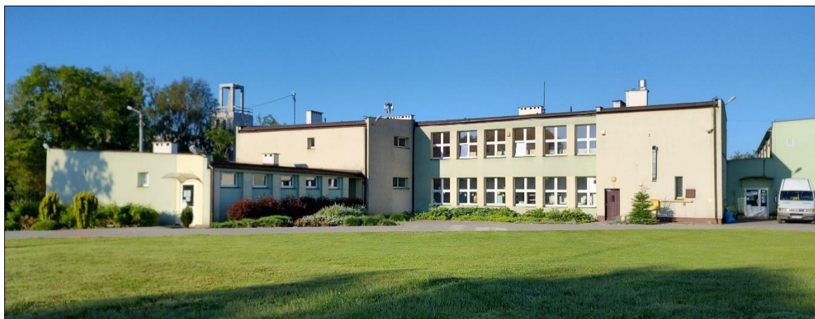
Rys. 18 Widok główny obiektu Szkoły Podstawowej w Przejazdowie zarejestrowany z kierunku północno-wschodniego.
