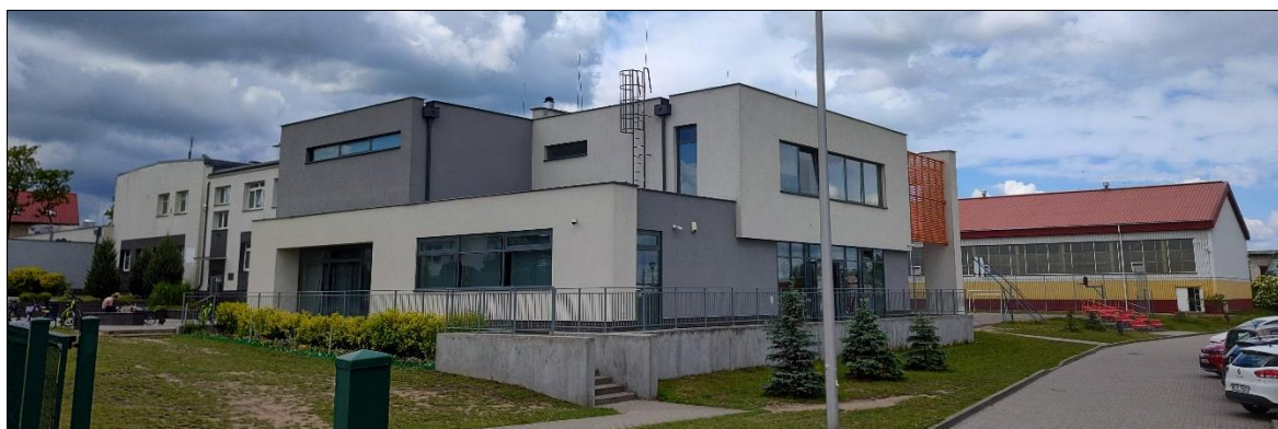
Rys. 14 Widok główny obiektu Szkoły Podstawowej w Łęgowie zarejestrowany z kierunku południowo-wschodniego.
