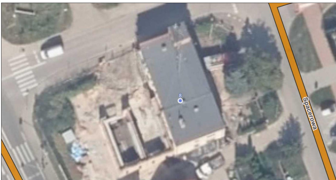
Rys. 47 Widok satelitarny połaci OSP w Łęgowie. Obszar zabudowy modułami na zdj. jeszcze w trakcie prac budowlanych.
