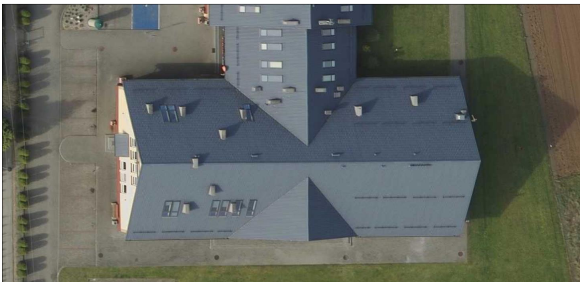
Rys. 43 Widok satelitalny połaci dachowych OKSiBP w Ciepłowie predestynowanych do zabudowy modułami fotowoltaicznymi.
